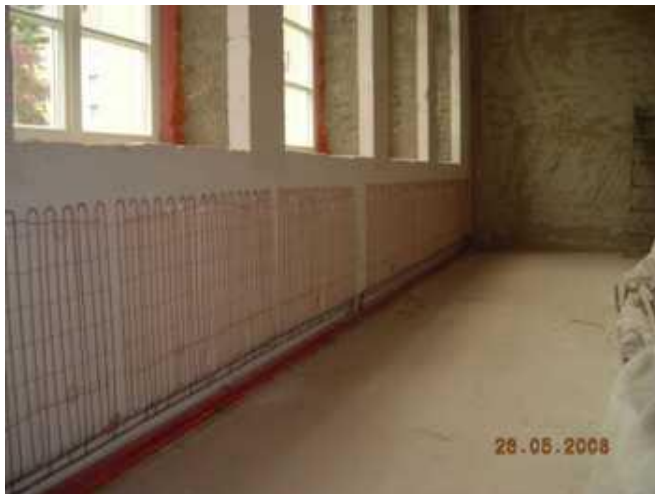
Wandheizelemente auf kapillaroffener Innendämmung (Mineralschaumstein)
