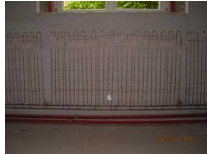
Wandheizelemente auf kapillaroffener Innendämmung (Mineralschaumstein)
