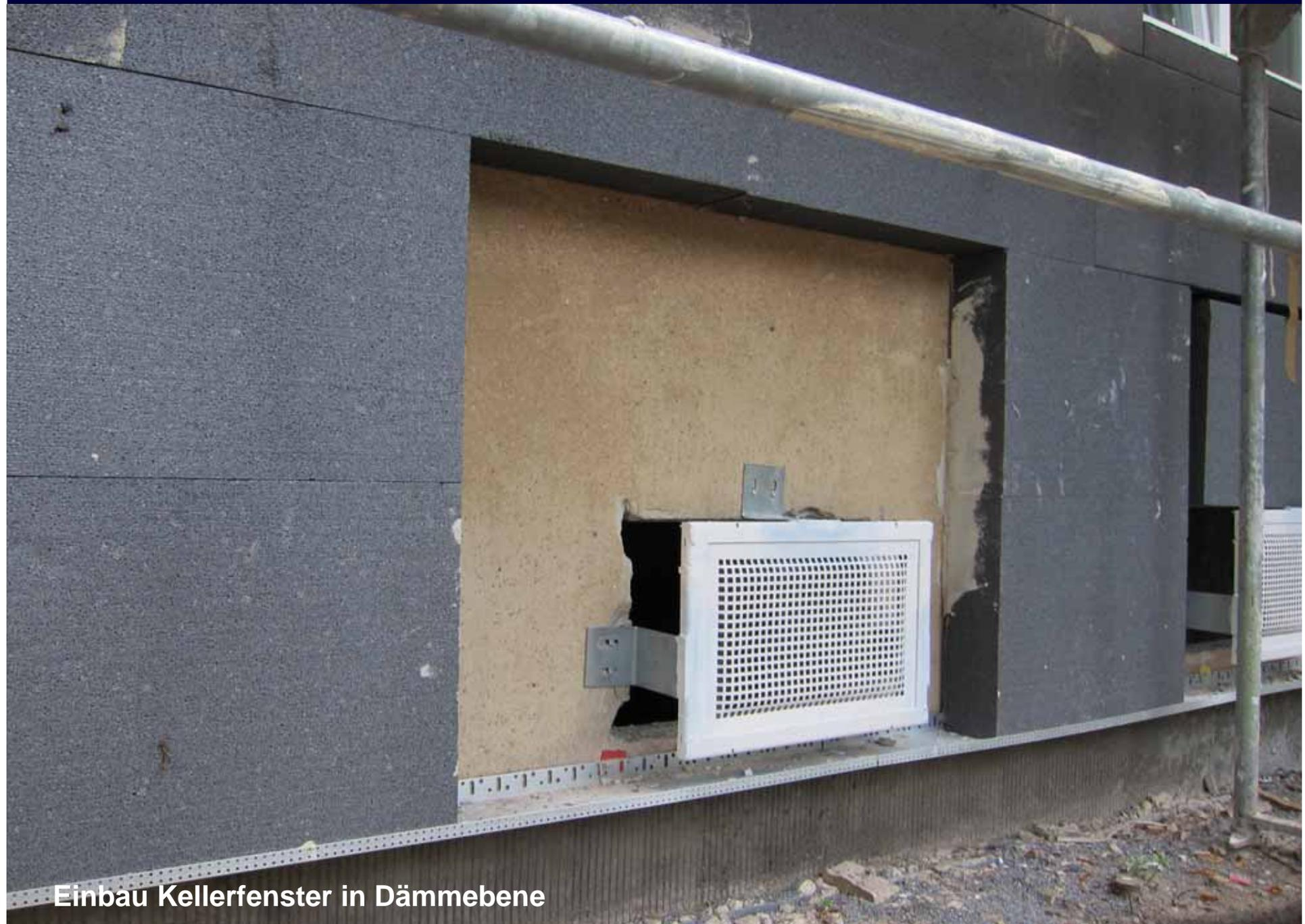
**Einbau Kellerfenster in Dämmebene**
