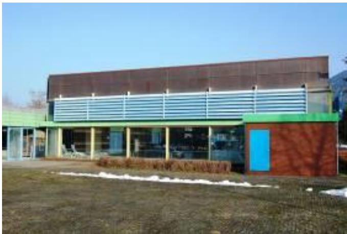
Schwimmhalle: „blinde“ Glasflächen
