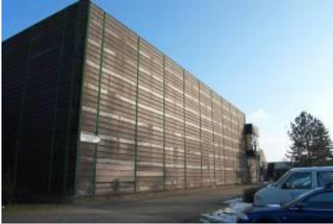
Turnhalle: fensterlos mit Lichtpyramiden auf dem Flachdach
