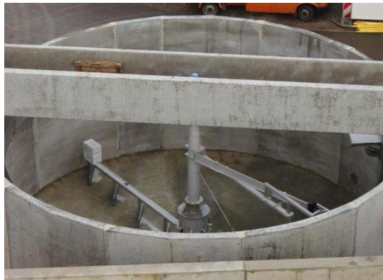
Installation Vorklärung im vorhandenen Belebungsbecken
