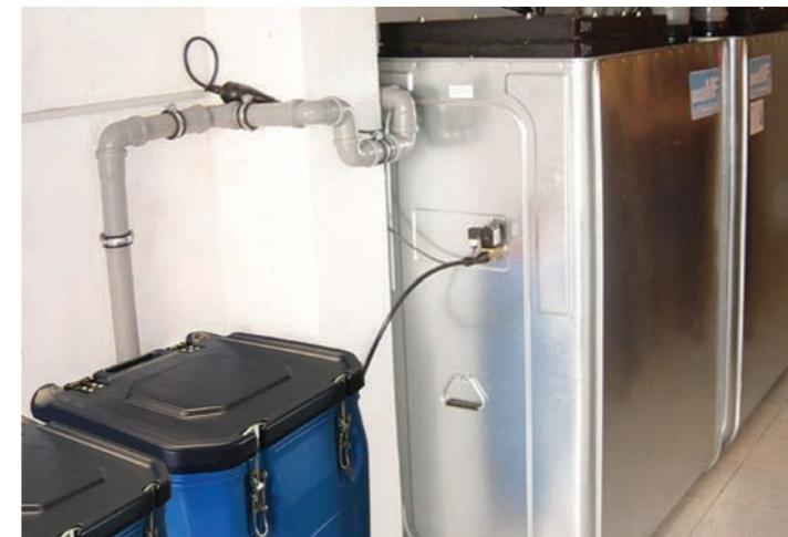
Die neue Phosphor-Eliminierungseinheit wird einer Membrankläranlage für einen 4 Personen-Haushalt/Einfamilienhaus nachgeschaltet.
