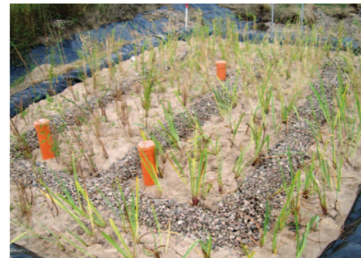
Betriebsbereite Kleinfilteranlage im technischen Maßstab mit Bepflanzung und Beschickungswerk
