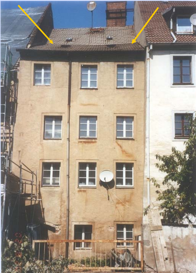
Hofansicht, zu geringe Dachneigung
