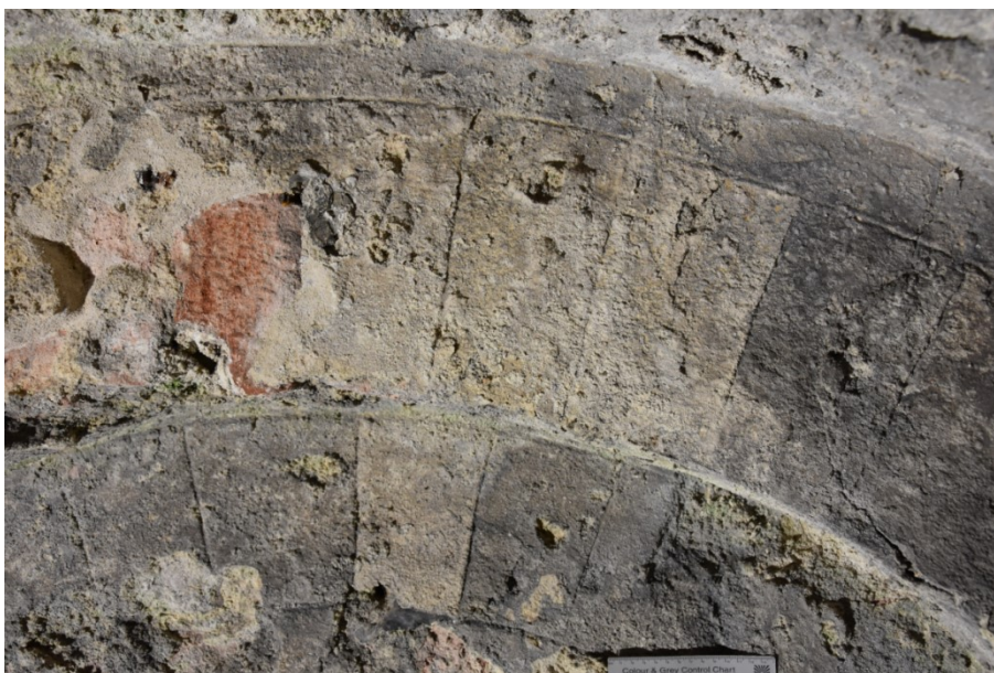
Abb. 10: Zwischenstadium bei der Laserreinigung des mittelalterlichen Putzes mittels Lasergerät (Aufnahme K. Keller).
