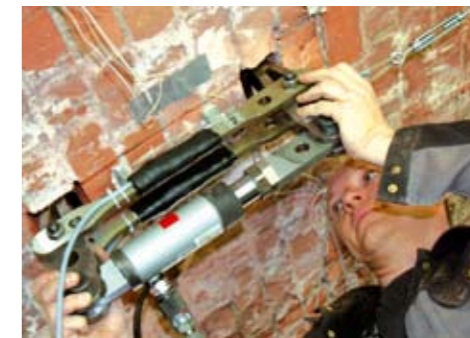
Dehnungsermittlung an Mauerwerk
