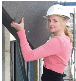
Auszubildende bei der Montage eines Dämmstoffblocks für das Technikhaus
