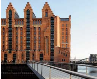
Blick auf den Kaispeicher in der Hamburger Speicherstadt (Foto Remmers)
