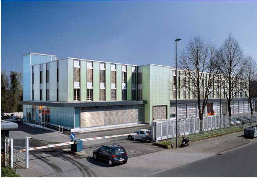
Bei der Sanierung des 60er-Jahre-Betriebsgebäudes der Remscheider Entsorgungsbetriebe wurde auf Energie- und Ressourceneffizienz Wert gelegt.
