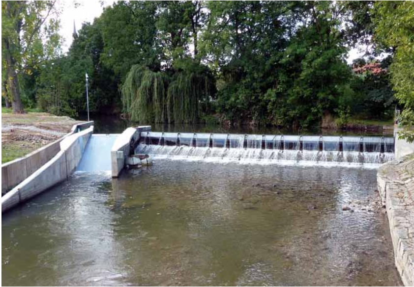
Die neue Kleinwasserkraftanlage am Illmwehr im Kurpark von Bad Sulza
