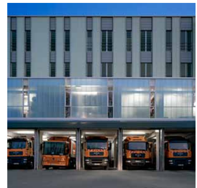
Nach der Modernisierung: 75 % weniger Energiebedarf
