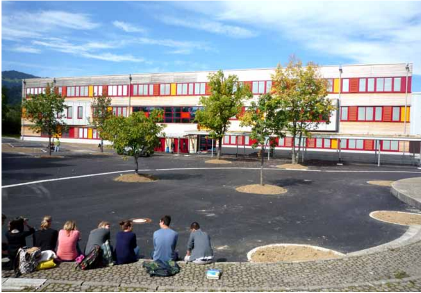
Holz verdeckt Beton: das Gymnasium Sonthofen nach der Sanierung
