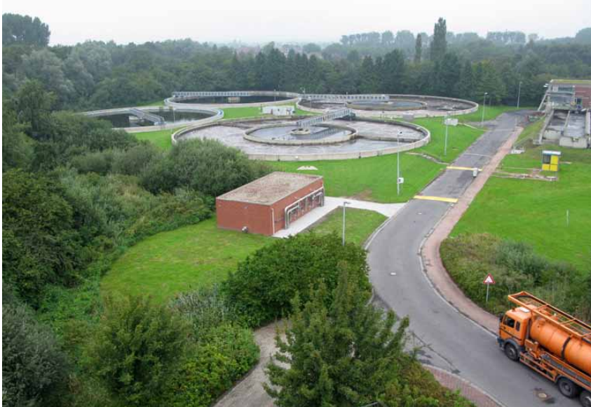
Am Beispiel der Kläranlage in Emden wurde das Energie-Einsparpotenzial ermittelt.
