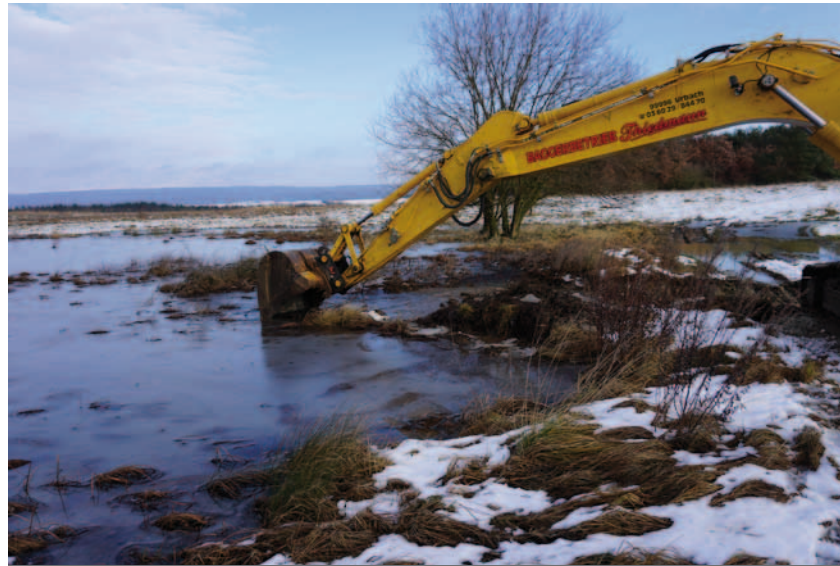
Entschlammungsmaßnahmen auf der DBU-Naturerbefläche Forstberg
