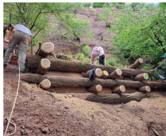
Schutz vor Geröll und Schlamm: Freiwillige des Bergwaldprojekts haben im Naturpark Soonwald-Nahe Holzboxen zum Erosionsschutz errichtet.
